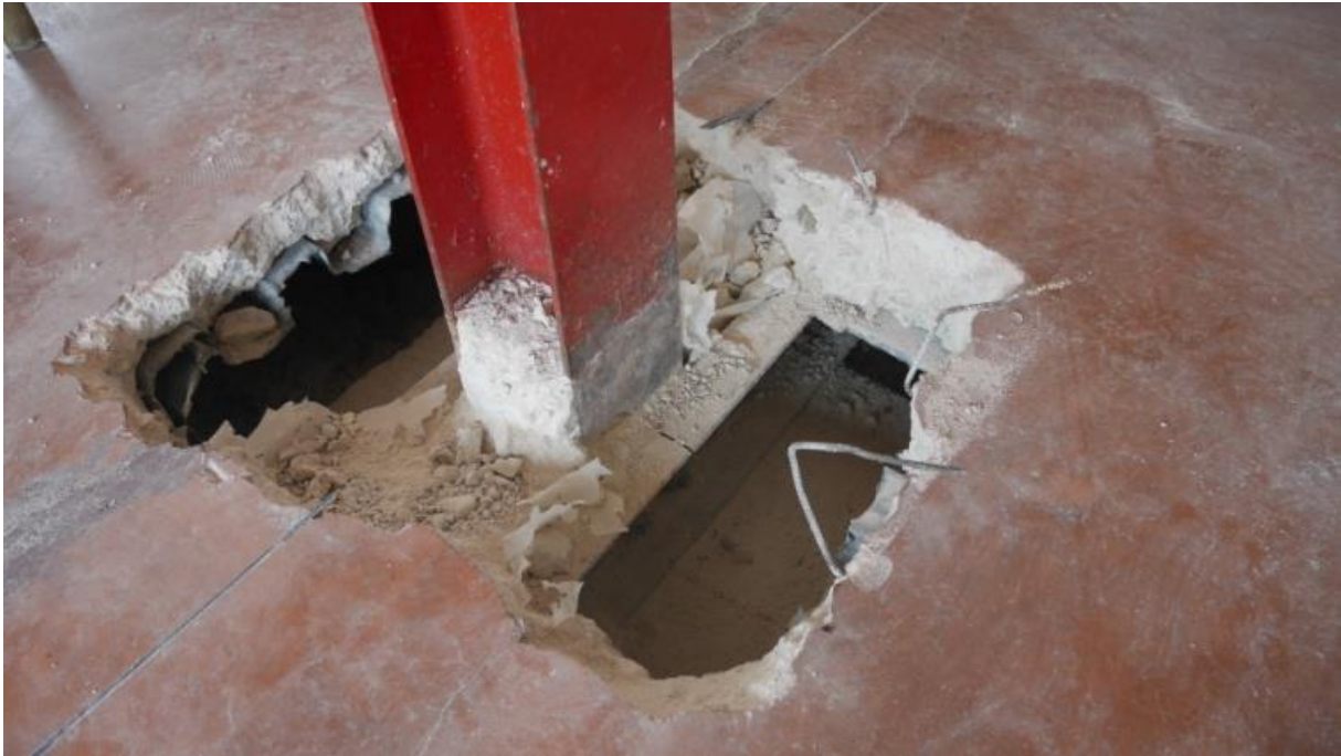
Foto 11 – Particolare collegamento a quota pavimento degli HEA 140 con travi UPN 140
