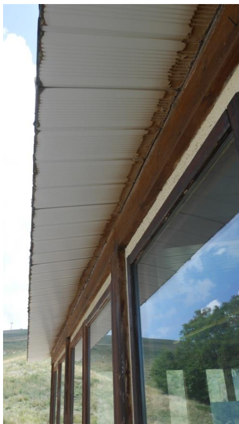
Foto 13 Spostamento tra parete Nord (verso l'interno) e pannello di copertura
