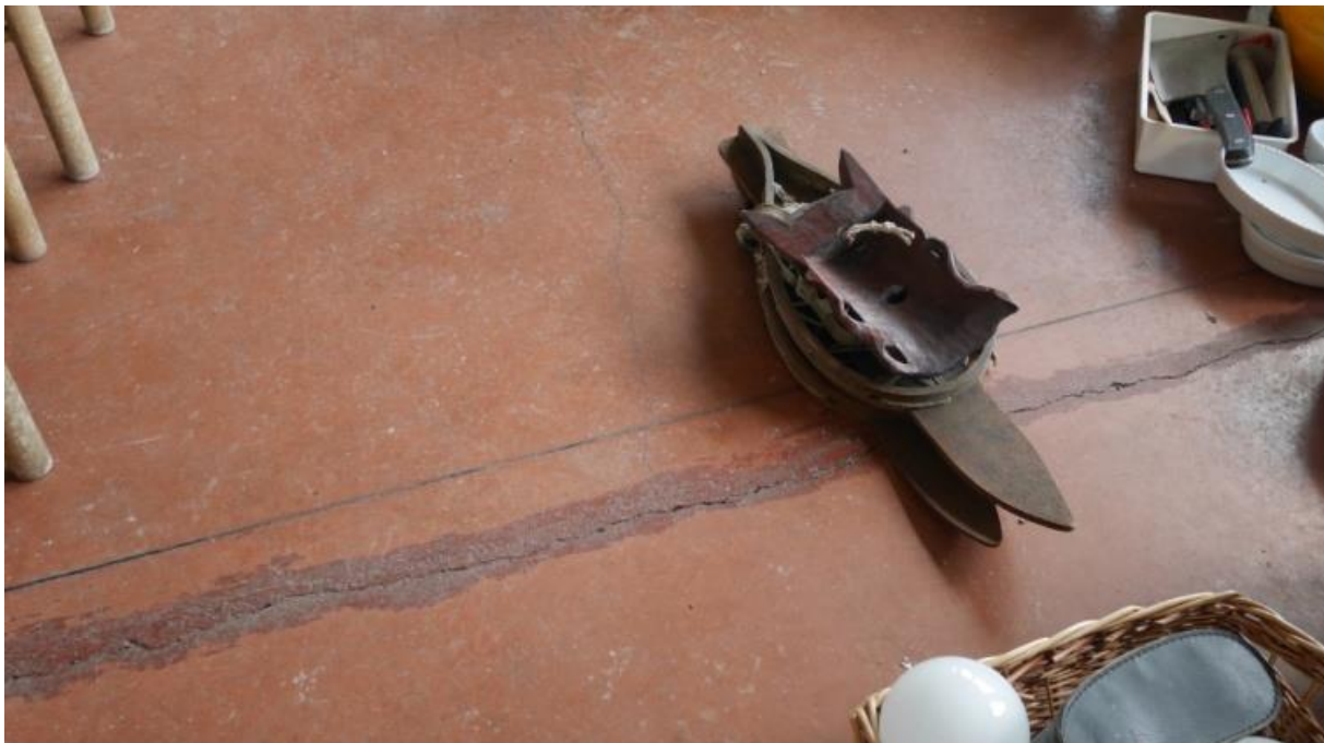
Foto 10 – Riapertura delle filature in corrispondenza delle travi UPN di collegamento dei plinti di fondazione
